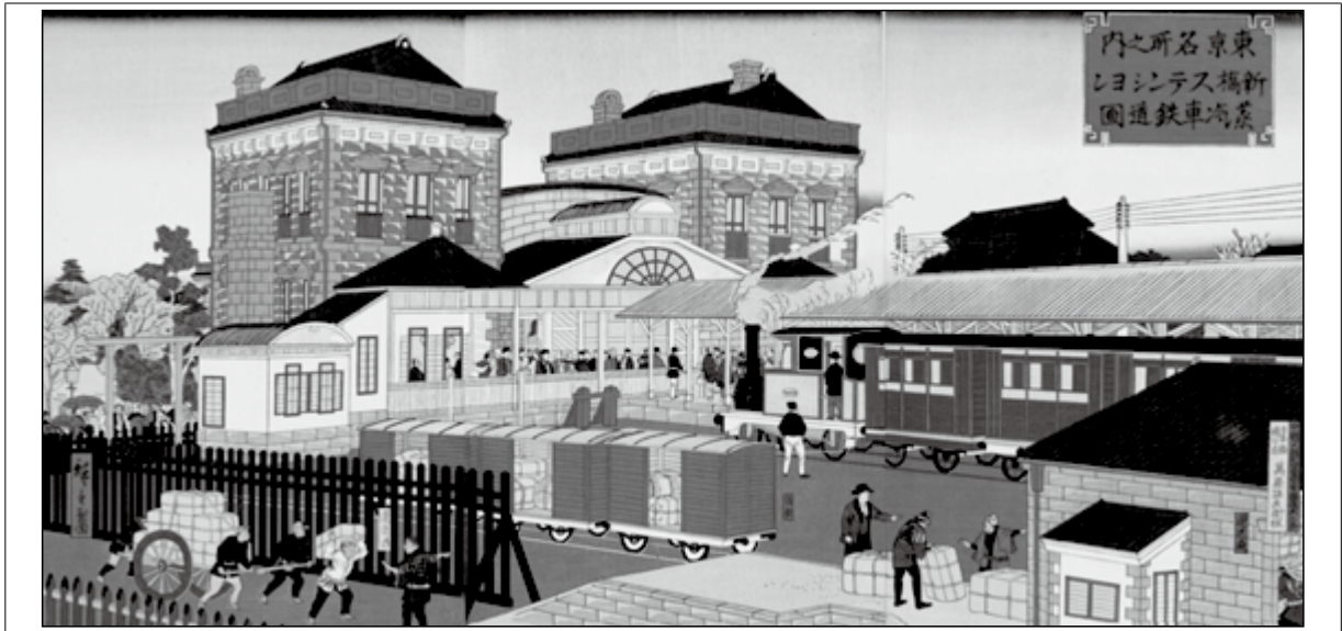
(歌川広重〈3代〉画「東京名所之内新橋ステーション 蒸気鉄道」)
